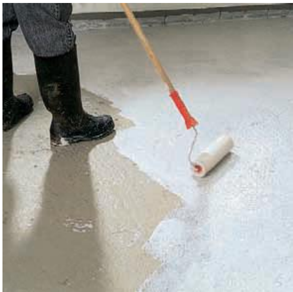
Primning av golv Rollas eller skrapas ut på golvet
